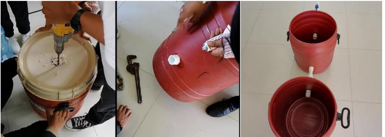
En la primera etapa se muestra el barrenado con taladro en los bidones, en la segunda etapa se aprecia la parte de aplicación de limpiador de PVC y pegado de las tuberías y en la tercera parte se puede apreciar la unión de ambos bidones, los cuales servirán como almacenamiento de la materia orgánica durante el proceso de fermentación.
